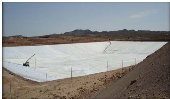
شکل ۱. لندفیل آرادکوه (در حال ساخت)
