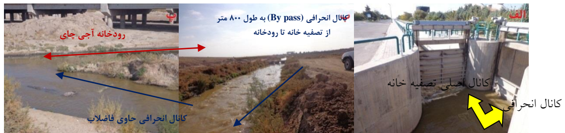
شکل ۳. الف) دریچه‌های کشویی ورود فاضلاب به کانال اصلی، ب) کانال انحرافی، پ) تخلیه فاضلاب به آبی چای
