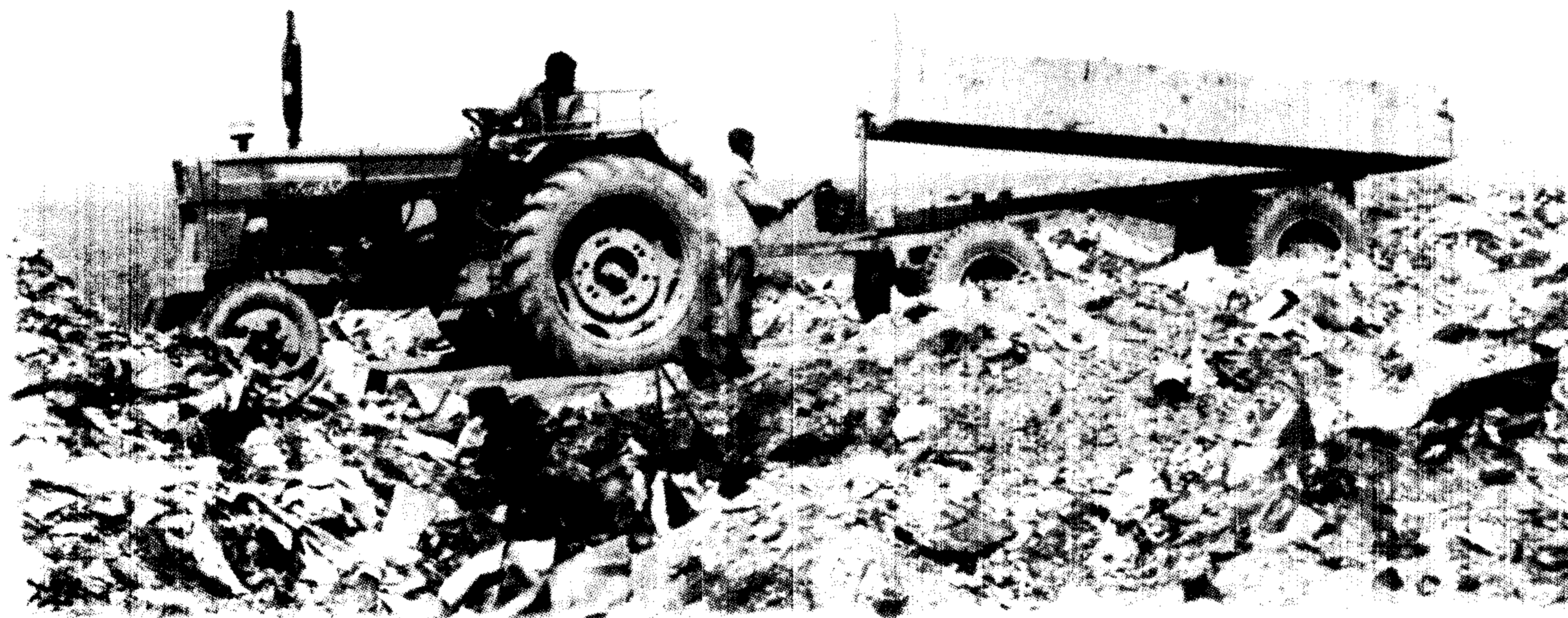
شکل شماره ۱۸ - تریلر یدکی در حال تخلیه زباله با استفاده از نیروی هیدرولیکی تراکتور
