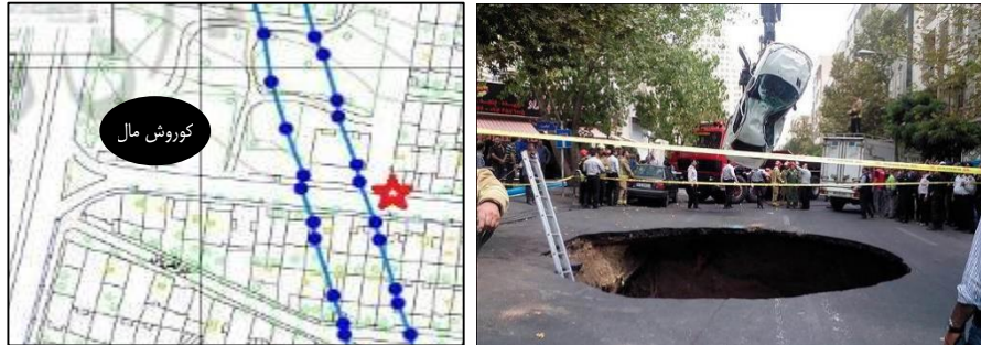
شکل ۱۹. مجاورت محل فروریزش زمین خیابان پیامبر با رشته قنوات و کارگاه گودبرداری مرکز تجاری کوروش در سال ۱۳۹۵ (Road, Housing & Urban Development Research Center, 1395)
