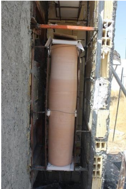
شکل (۲-ب). دو استوانه نصب شده در پایین کانال بادگیر (منبع: نگارندگان)
