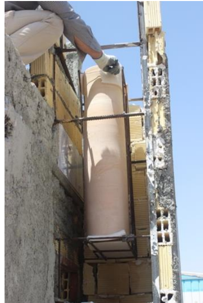
شکل (۲-الف). دو استوانه نصب شده در بالای کانال بادگیر (منبع: نگارندگان)
