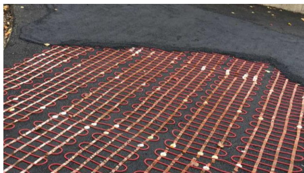
شکل ۴. نمونه اجرای شبکه لوله‌های سیستم گرمایش هیدرونیک در زیر روسازی (منبع فناوری: Mirzananamadi et al., 2019)
