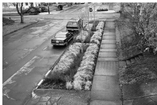
شکل ۵. جمع‌آوری رواناب از سطوح کف‌سازی و هدایت آن به باغچه‌ها به صورت تدریجی و در زمان مورد نیاز
