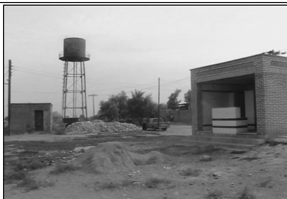
شکل شماره (۱۴): نزدیکی چاه فاضلاب به چاه آب شرب روستای بنه‌عیسی (فاقد دستگاه کلرزی)
